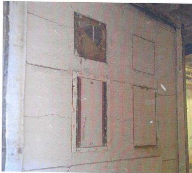
Figura 22 – Lado expuesto de la muestra ensayada.
