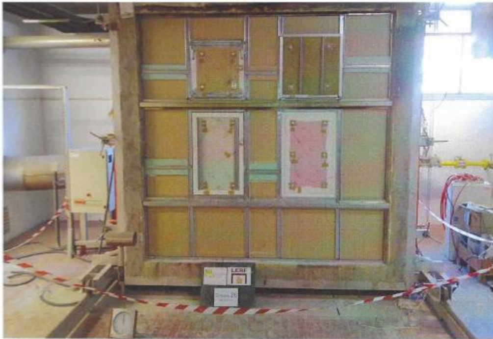
Figura 2 – Lado no expuesto de la muestra a ensayar
